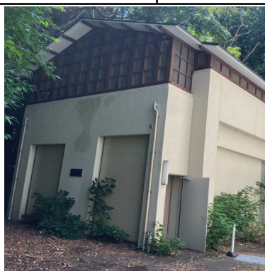
大隈ポンプ場
