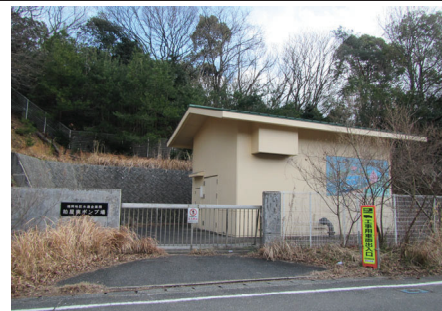
粕屋南ポンプ場
