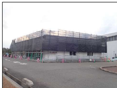
建設状況 (令和7年1月)
