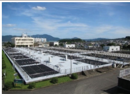
牛頸浄水場 ろ過池
