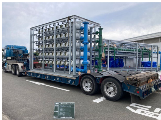
浸透膜設備搬入 (令和6年10月)
