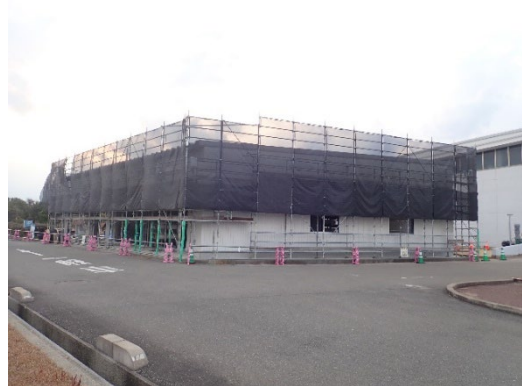
建屋建築 (令和7年1月)
