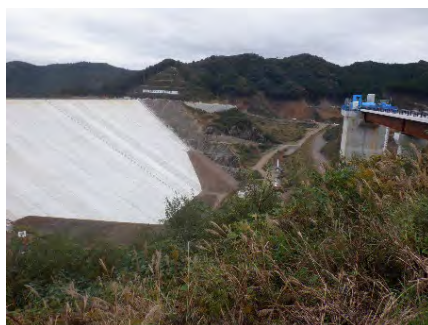
南摩ダム堤体
