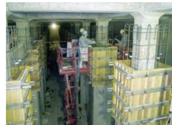
配水池の耐震化工事 (内面からの壁・柱等の補強)
