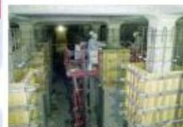
配水池の耐震化工事 (内面からの壁・柱等の補強)
